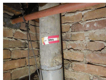
MM04 Monsterlocatie, de buis gaat in de koker tot de eerste verdieping naar het toilet.
