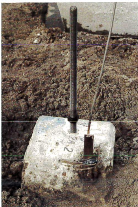
1. Paalkop met draadeind, stelmoer en aardleiding
