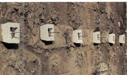
1. Pilaalop met draadring, slimoer en aaridring
